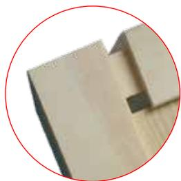
Assemblage par tenon et mortaise
