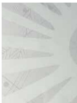
Procédé de dépolissage et de gravure du verre obtenu par projection puissante de sable suivant un modèle de pochoir. Possibilité, grâce à cette technique, d'obtenir des degrés d'opacité nuancés (variations de gris) et colorés (bleu, vert, jaune, rouge, gris taupe). Convient à tous les styles, modernes et traditionnels.
